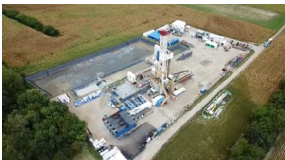
Figure 4: Illkirch drill site in Alsace (Electricité de Strasbourg)
