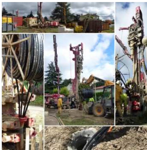
Le chantier de forage pour l'installation des sondes géothermiques. (Crédit : BET SDTECH)
