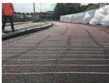
Mise en œuvre de l'échangeur - Démonstrateur D1
