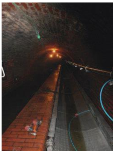
Le capteur installé dans la canalisation Crédit photo : Lyonnaise des Eaux
