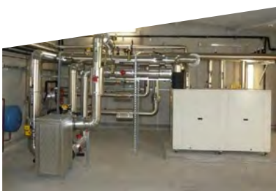
Le local pompe à chaleur
