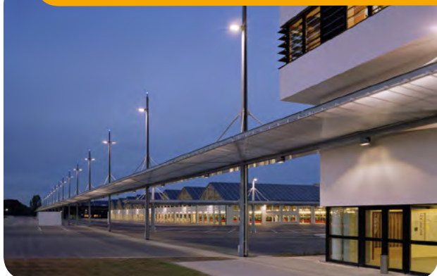
L'ensemble du Centre de maintenance des bus et tram du Grand Dijon (Crédit : Renaud ARAUD Photographe)
