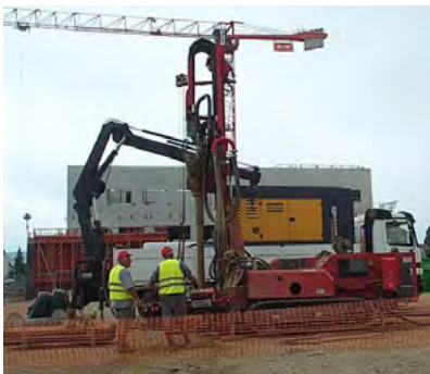
Le forage d'une des 15 sondes mises en œuvre sous la future aire de stationnement du bâtiment
