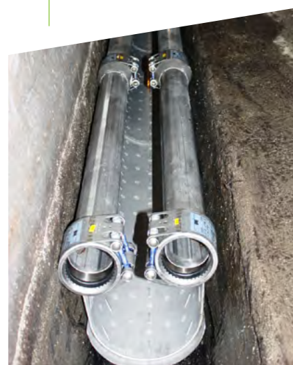
92 m 2 d'échangeurs sont placés dans les 176 m de canalisations d'eaux usées
