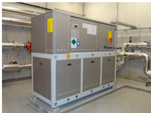
La pompe à chaleur de 360 kW de puissance thermique puise la chaleur dans le réseau d'eaux usées de Dijon.
