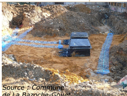
Raccordement des sondes au collecteur
