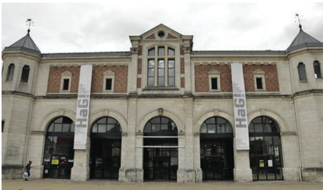
Halle aux grains de Blois © S2e2, Région Centre-Val-de-Loire
