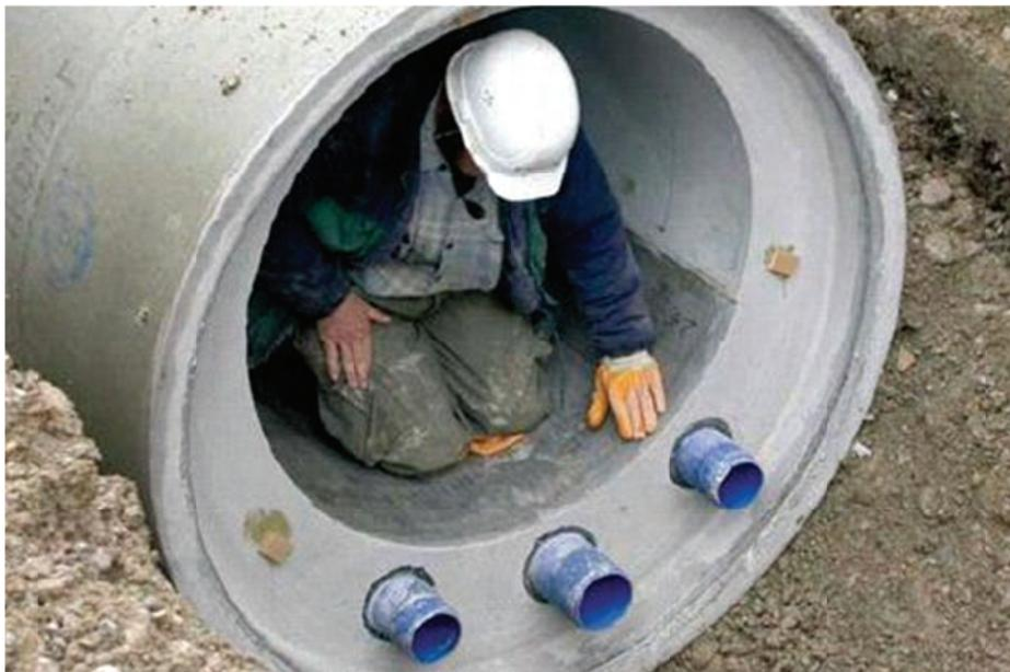
Figure 13 - Principe de fonctionnement d'une PAC sur réseaux d'eaux usées : Illustration de canalisation avec capteurs préfabriqués (source Rabtherm)
