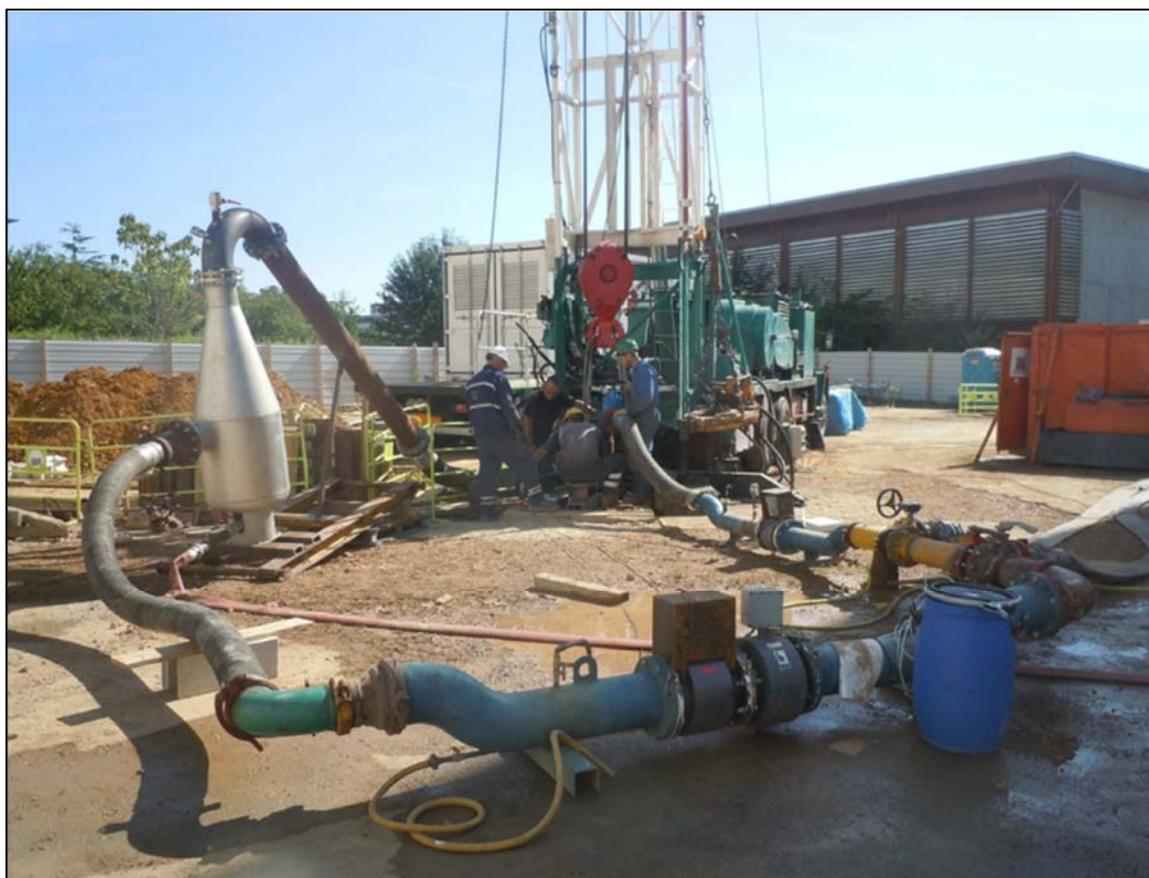
Figure 16 : Photographie de l'hydrocyclone mis en place pour les essais du puits producteur LPR-1.
