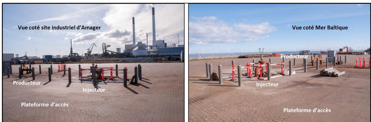
Figure 3 : Têtes de puits du doublet de Copenhague sur le site industriel d'Amager (mars 2016).
