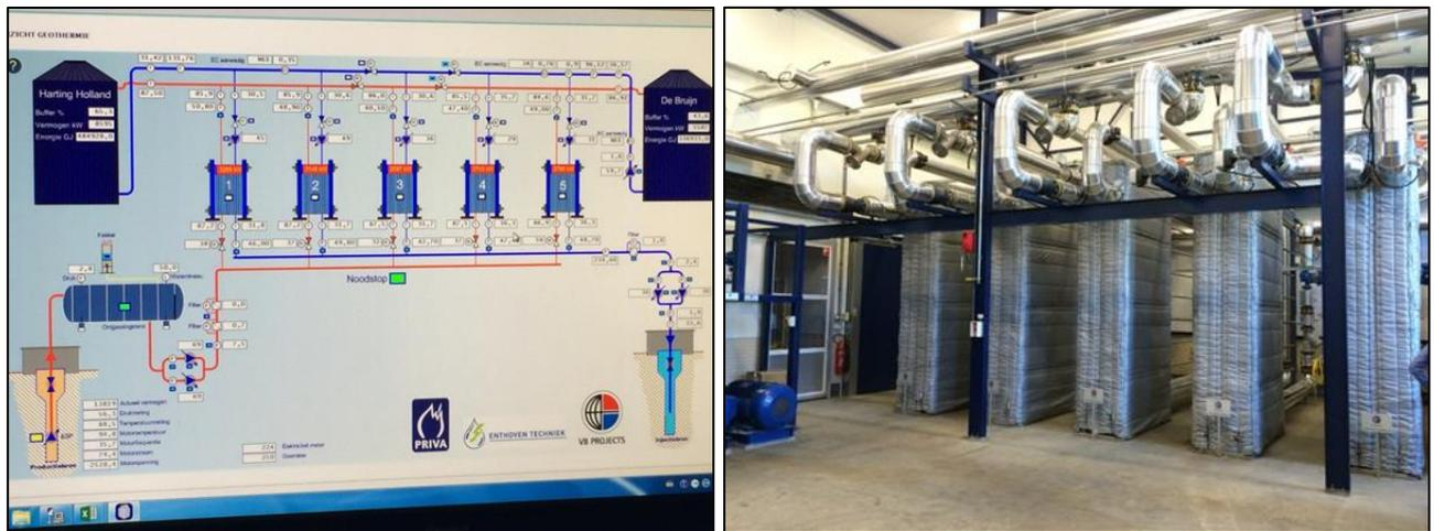
Figure 14 : Photographies du système de monitoring et des échangeurs de la centrale géothermique de De Lier (juin 2016)
