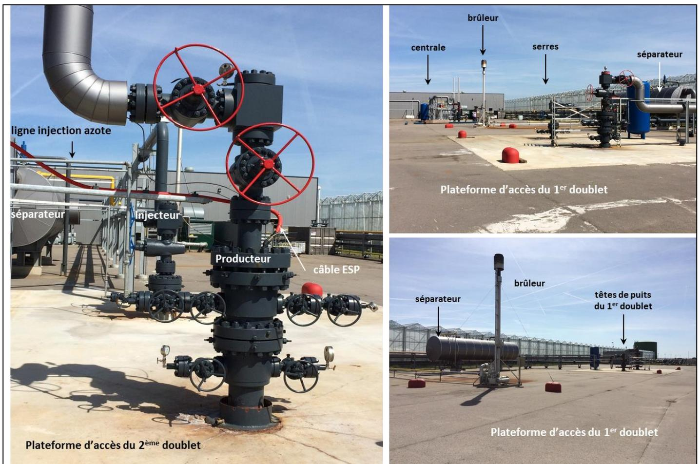
Figure 10 : Photographies du site géothermique d'Agriport (juin 2016)
