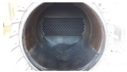
Echangeurs de chaleur avec présence de dépôts et traces de corrosion
