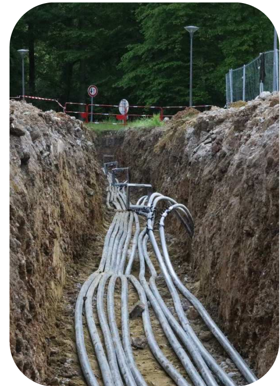
Tranchée de raccordement
