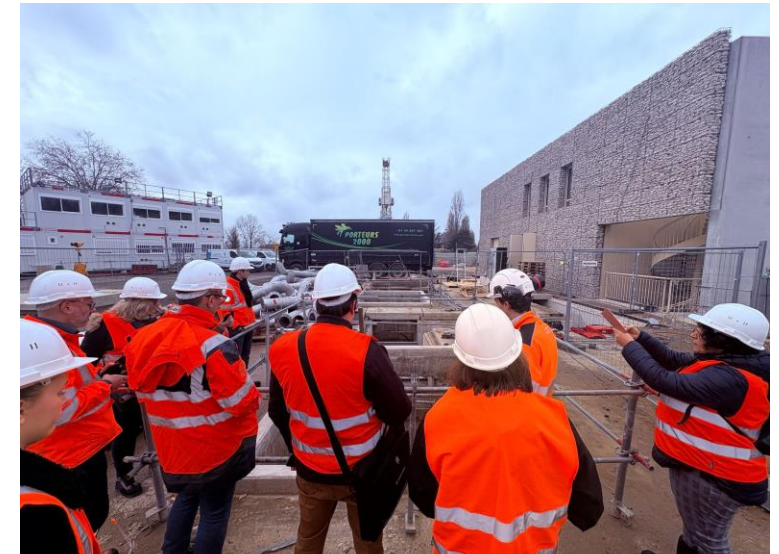
Visite de la centrale en construction au Chesnay-Rocquencourt le 10/12/2025
