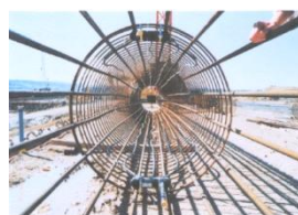
Armatures d'un pieu géothermique
