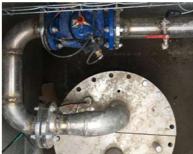
Vanne de stabilisation pour maintien de pression
