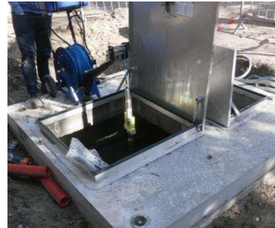
Inspection vidéo de l'ouvrage
