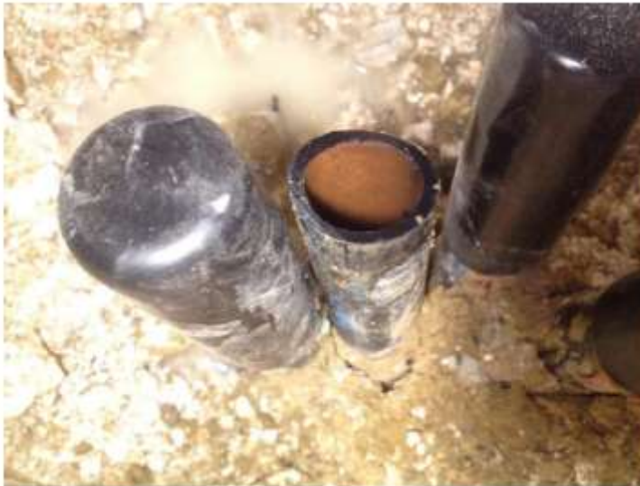
Paroi avec dépôt d'une sonde géothermique
