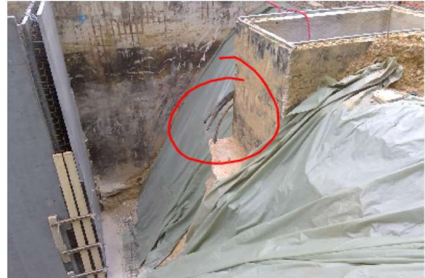
Raccordement des sondes verticales coupé
