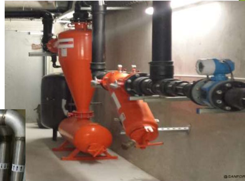
Dispositif de filtration pour 50 m 3 /h
