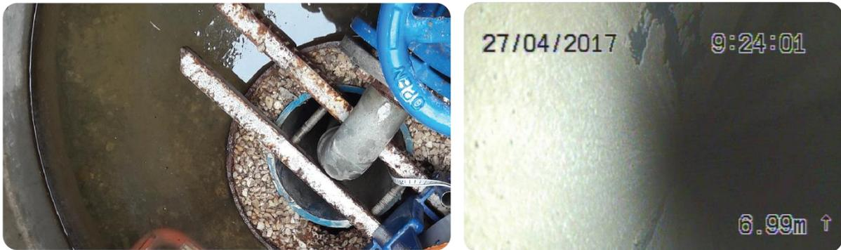
Figure 35 : Cave d'avant puits inondée lors d'événements pluvieux. Par débordement, les eaux s'infiltrent dans le massif de gravier et s'introduisent dans le forage de réinjection générant des dépôts carbonatés sur la surface interne du tubage plein.
