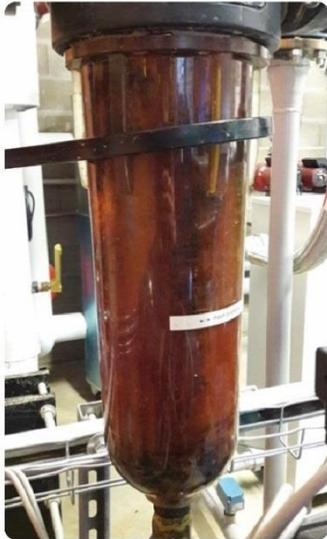
Figure 13 : Filtre à manchon colmaté par des oxydes métalliques
