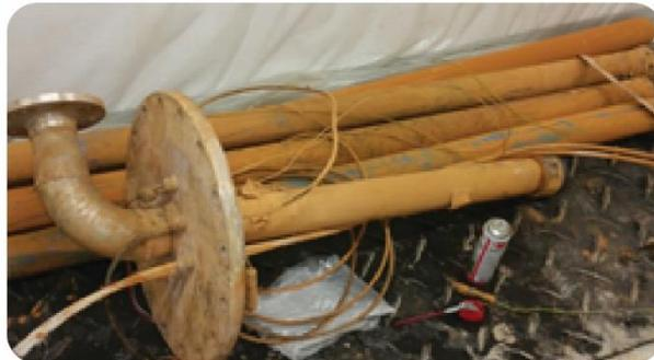
Figure 39 Colonne d'injection positionnée dans la zone de rabattement recouverte de dépôts d'hydroxydes de fer
