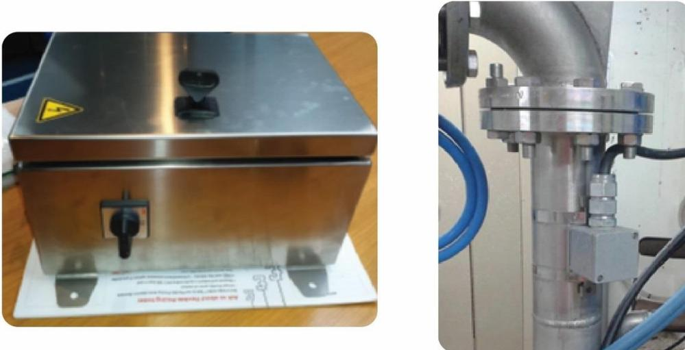
Figure 45 : Dispositif électromagnétique ST090 (à gauche boîtier de commande, à droite antenne)
