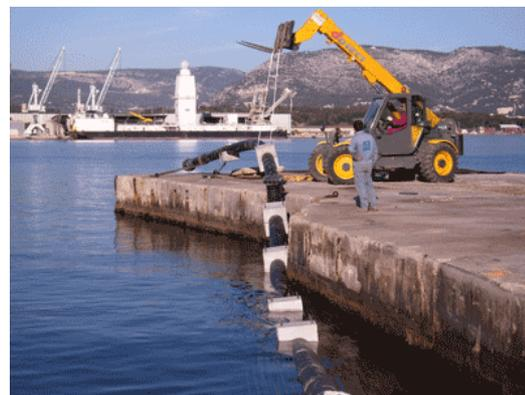
Figure 19 : pose canalisation de rejet (source Ville de La Seyne/mer)
