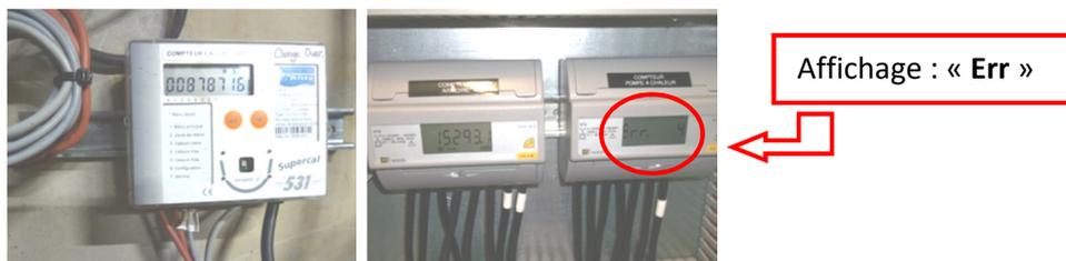
Figure 2 Compteur d'énergie correctement positionné et actif (à gauche) – Compteur électrique défectueux (à droite)
