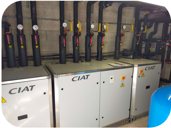
Pompe à chaleur géothermique intégrée au bâtiment
