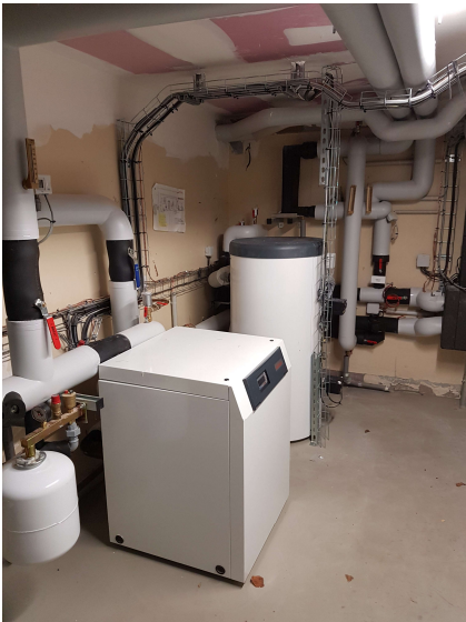
Local de chaufferie intégré au bâtiment
