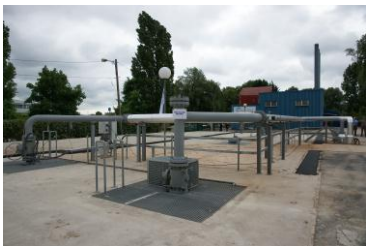
Extérieur de la centrale géothermique de Chelles
