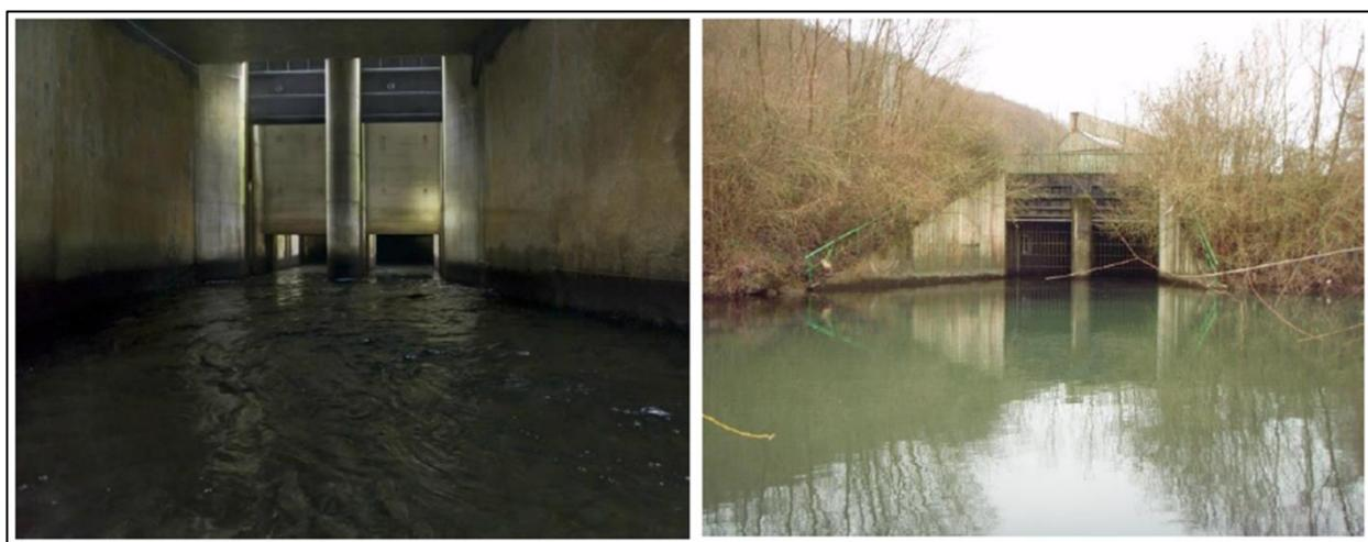
Figure 73 : Vues des vannes à guillotines (à gauche) et du rejet dans l'Orne (à droite).
