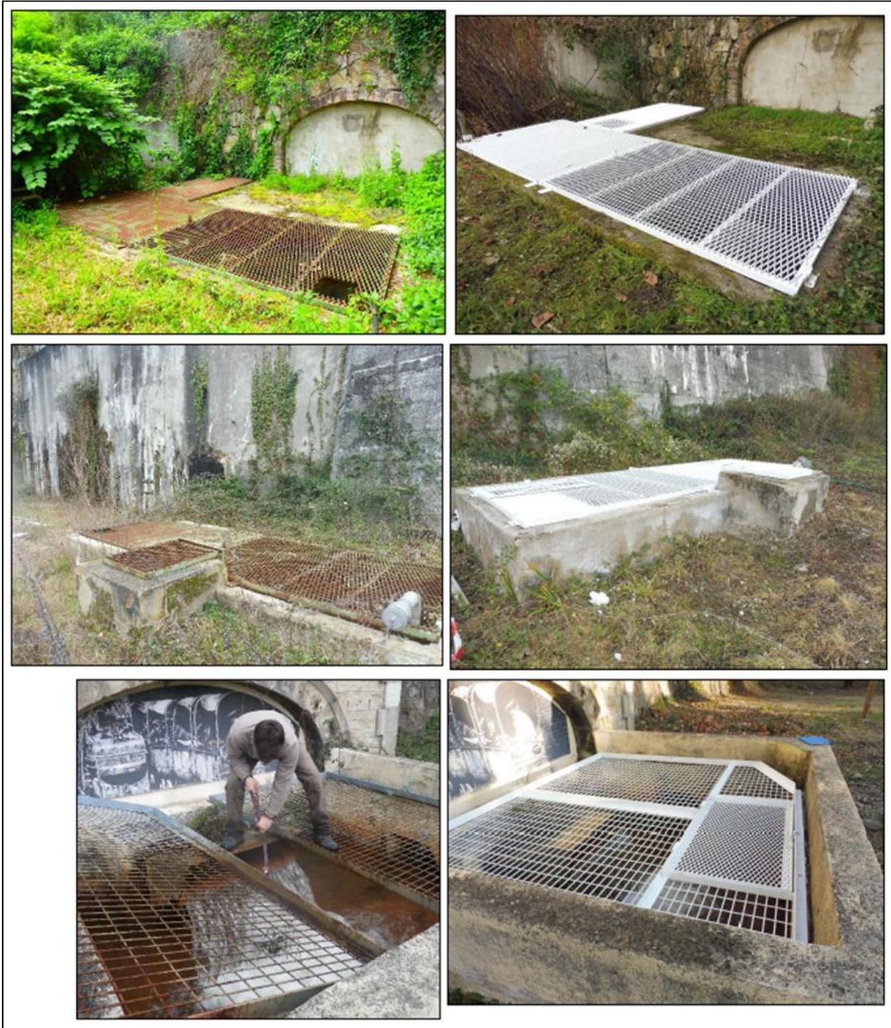
Figure 12 : Vues des émergences de Chalmeton (en haut), Silhol (au milieu) et Sainte-Barbe (en bas) : grilles d'accès avant (à gauche) et après travaux (à droite) - Source : Hoang, 2019.
