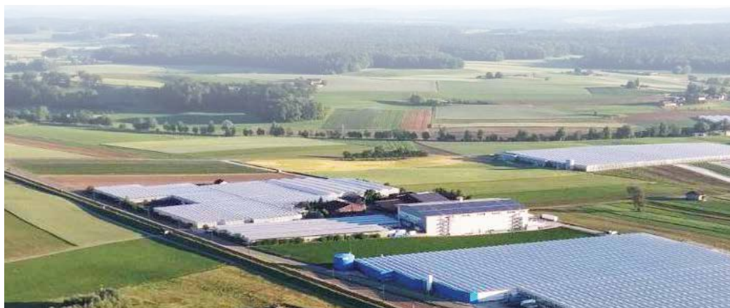
Figure 10. Serres horticoles de l'entreprise Grob à Schlattingen et illustration du dispositif de forages profonds (source : Geothermie-suisse)
