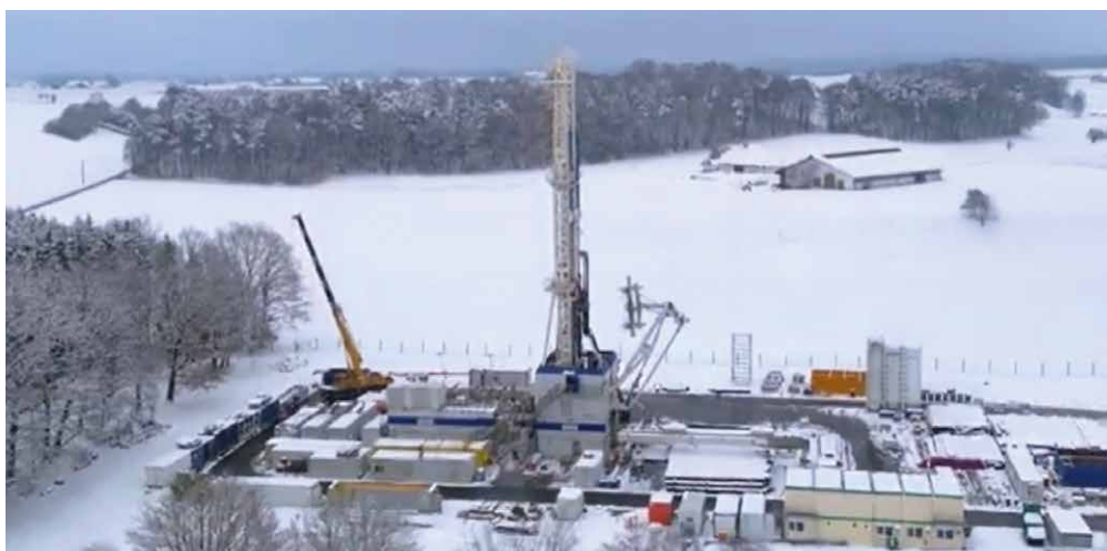
Figure 12. Site du forage du 2nd doublet près de Halsbach (source : Segnung des Bohrmeissels – Geothermie Naturwärme video)
