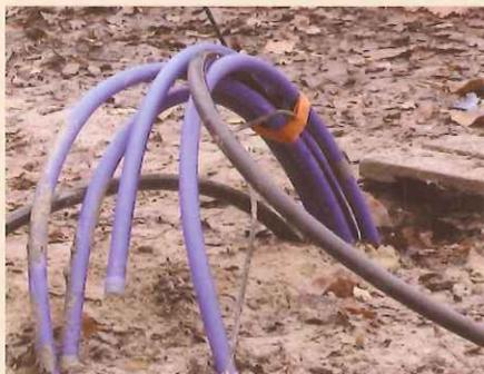
Tête de sonde après insertion dans le forage et cimentation.
