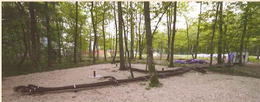
Vue d'ensemble des départs de sondes géothermiques.
